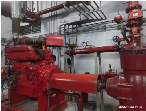
รูปที่ 12 เครื่องสูบน้ำดับเพลิง
