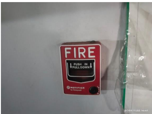
รูปที่ 14 สัญญาณเตือนเพลิงไหม้
