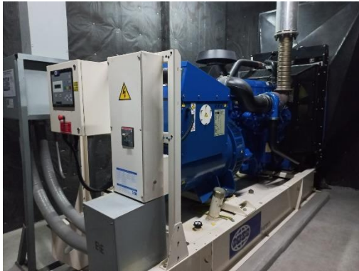
รูปที่ 30 เครื่องกำเนิดไฟฟ้าสำรอง
