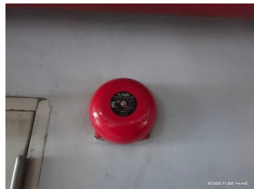
รูปที่ 14 สัญญาณเตือนเพลิงไหม้
