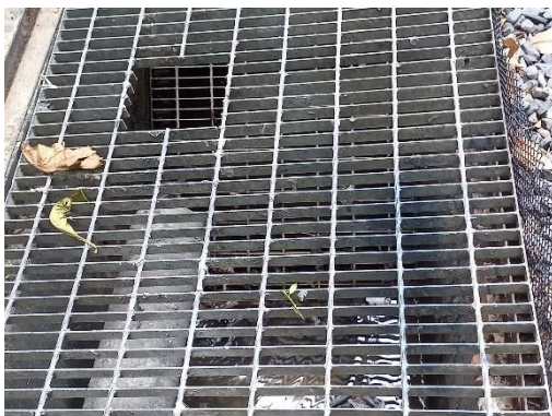
รูปที่ 28 ตะแกรงดักขยะ
